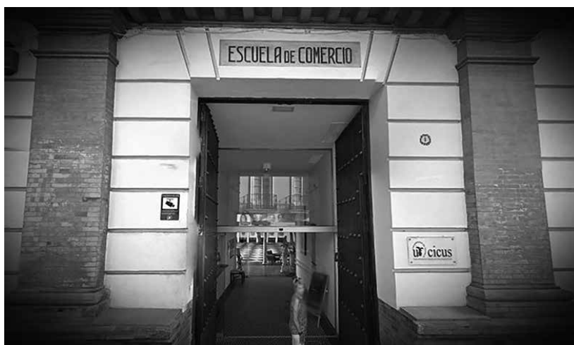
Figura nº 4. Edificio de la Escuela de Comercio en la C/ Madre de Dios nº 1, actualmente sede del Centro de Iniciativas Culturales de la Universidad de Sevilla (CICUS)
